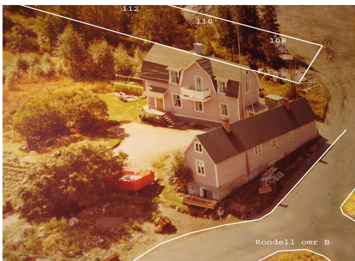
I gården bredvid nuvarande rondell föddes Sixten Öhman för 83 år sedan. Den vita linjen visar nuvarande byggnad ingång 108, 110, 112
